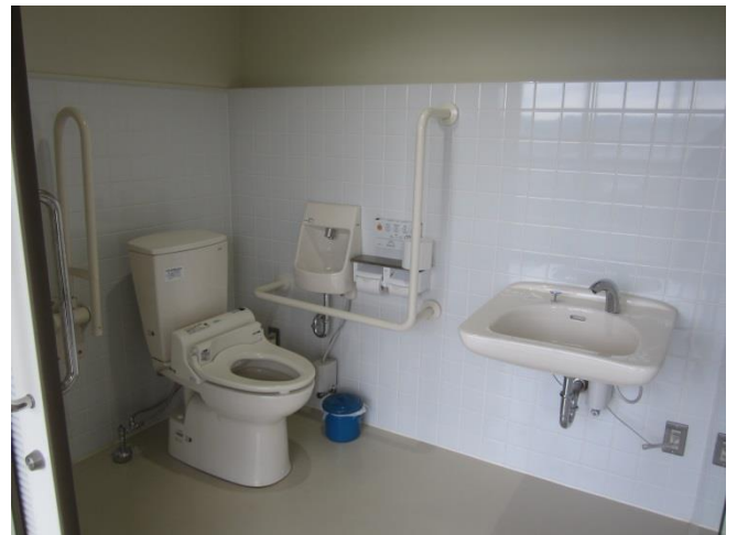
3 階 バリアフリー トイレ
